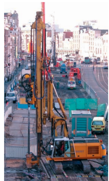
SMW-Ausrüstung mit Dreifachantrieb an RG 15T, Amsterdam, Holland SMW-attachment with triple drive on RG 15T, Amsterdam, Netherlands
