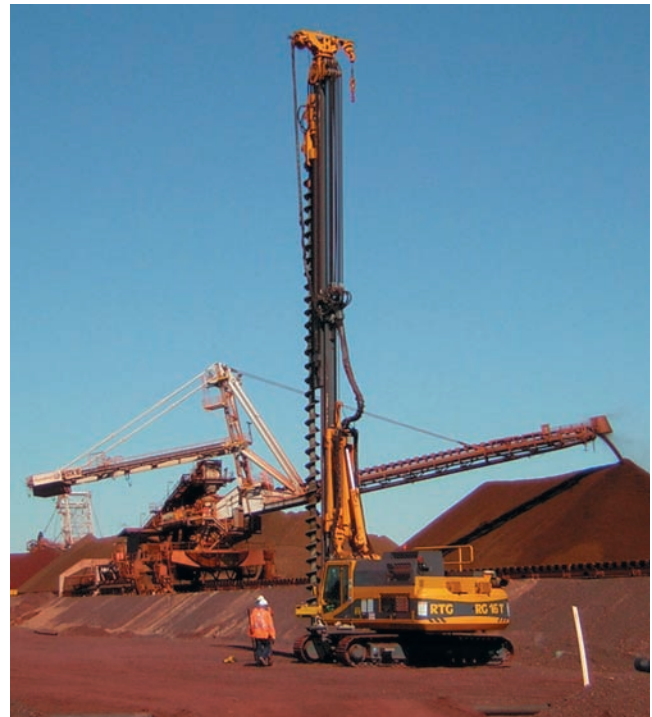
Vorbohren mit RG 16T und Endlosschnecke, Australien Predrilling with continuous flight auger on RG 16T, Australia
