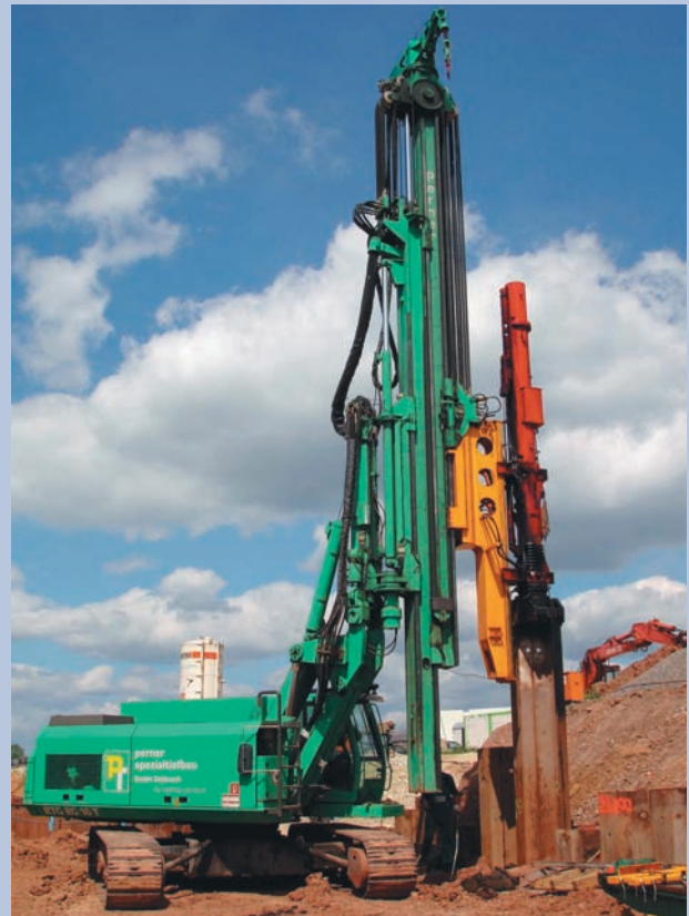
RG 16T mit Dieselbär RG 16T with Diesel-hammer
