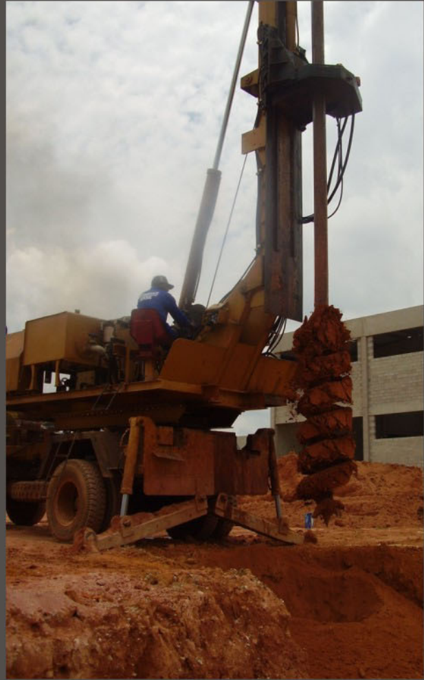
Triple guided kelly bar - Hste telescópica tripla guiada
