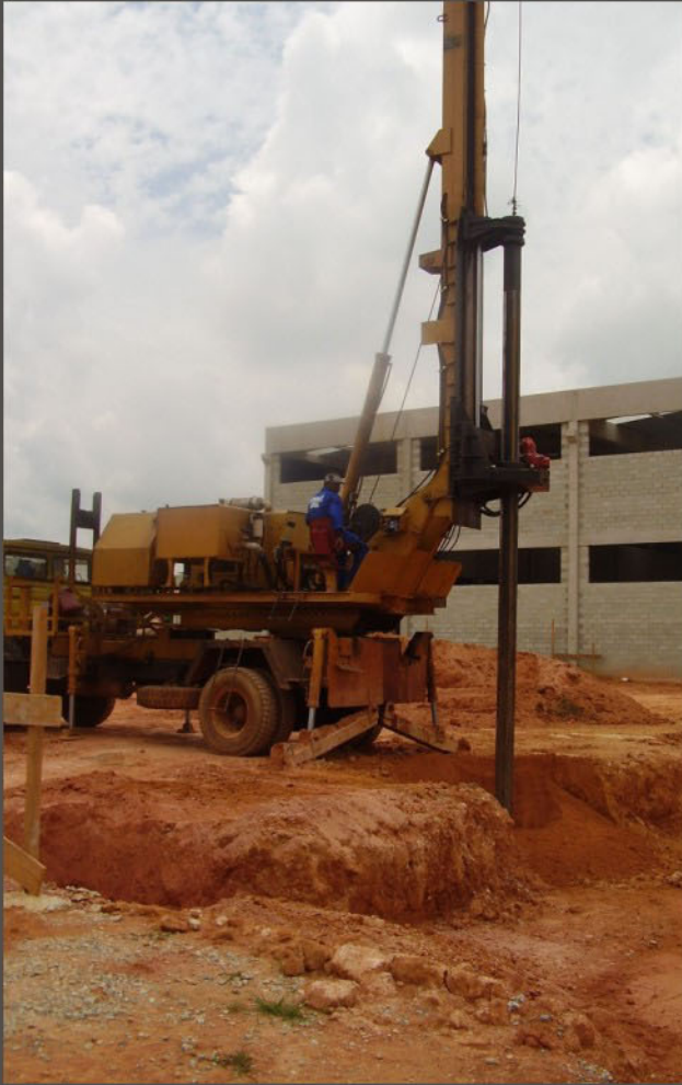
Triple guided kelly bar - Hste telescópica tripla guiada
