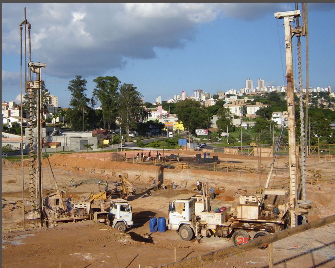
Única world wide CFA Bottom Drive Truck mounted Versão única em todo o mundo de CFA Bottom Drive sobre caminhão
