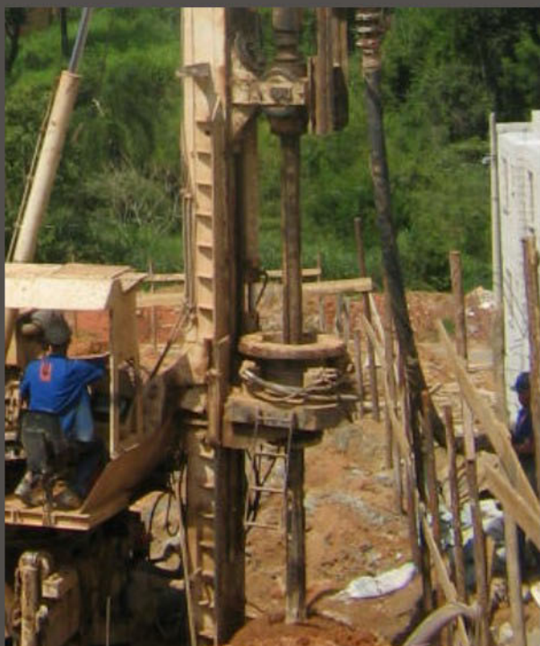
Auger and extension drilling - Perfuração com trado e com extensão
